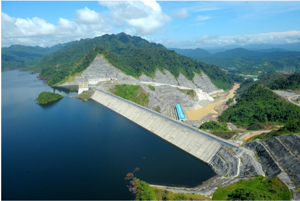
图注：巴贡水电站
