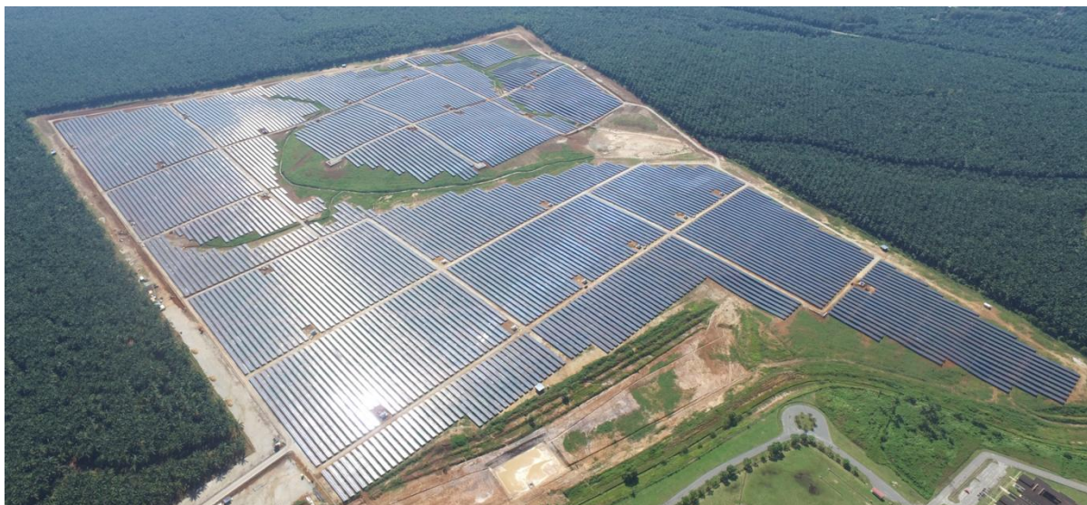
图注： 天津电建—马来西亚吉打州瓜拉基蒂 50 兆瓦光伏电站项目俯瞰图
